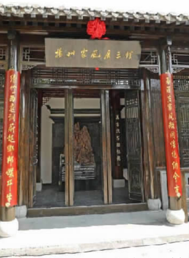
扬州家风展示馆外景。
